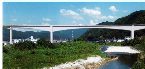
『令和3年度 中部縦貫下切高架橋PC上部工事』より
